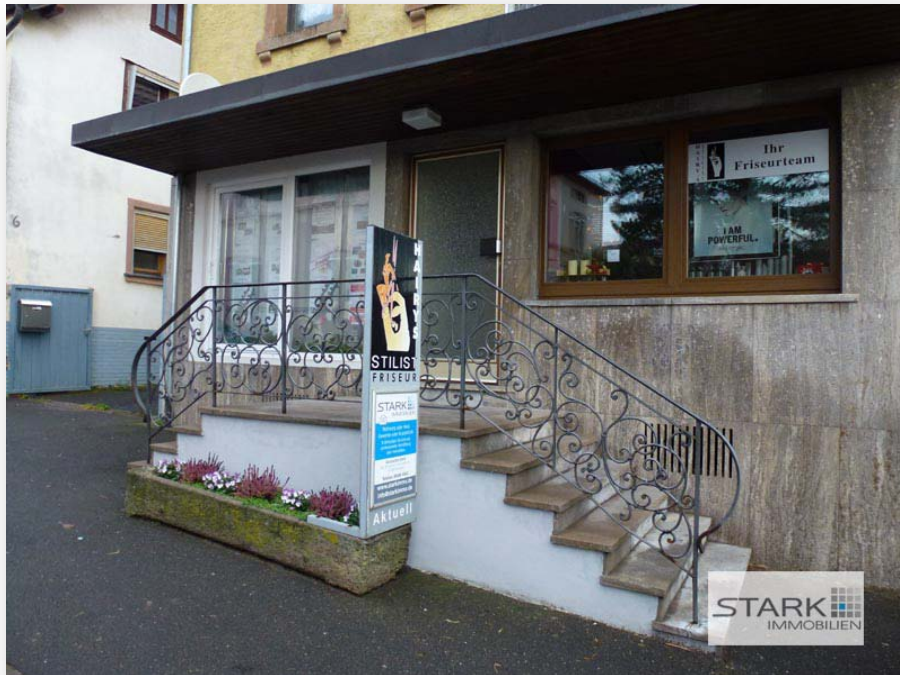
Außenansicht mit Eingang
